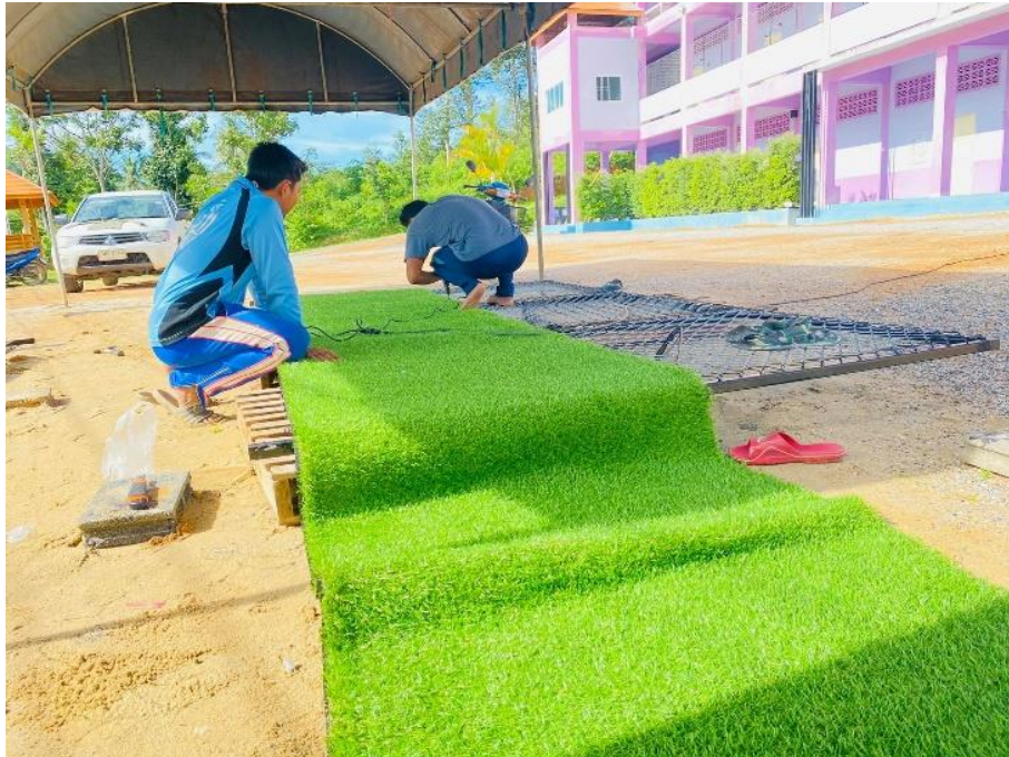
1. ซ่อมแซมอาคารเรียน
